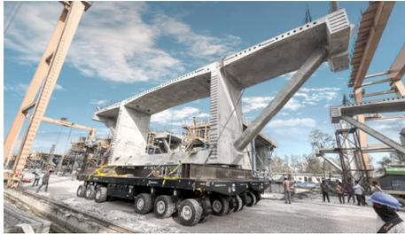
Seitlich gekuppelt befördern 2 PowerHoss Module 175 t schwere Brückensegmente bis zum Trägerwerfer.
